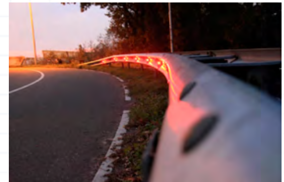
Vangrailverlichting met stroom van planten, Plant-e
